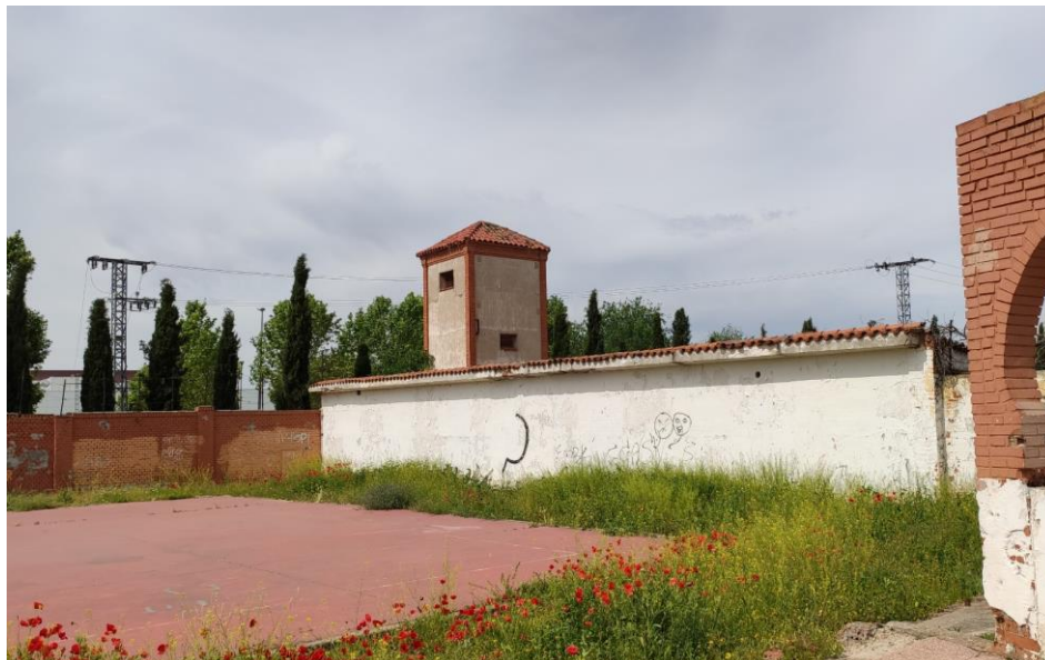
Ilustración 12. Centro de transformación existente situado al sur de la colonia. Fuente: Elaboración propia.
