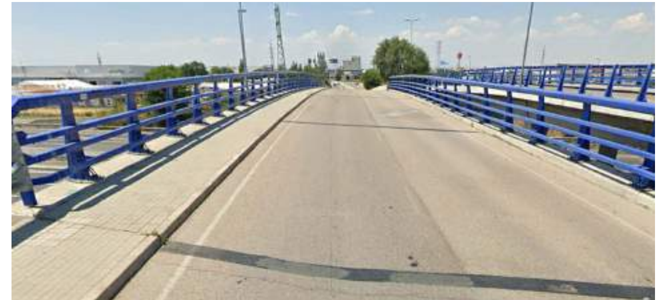
Imagen 21. Sección de Av. Daganzo sobre la autovía A-2.
