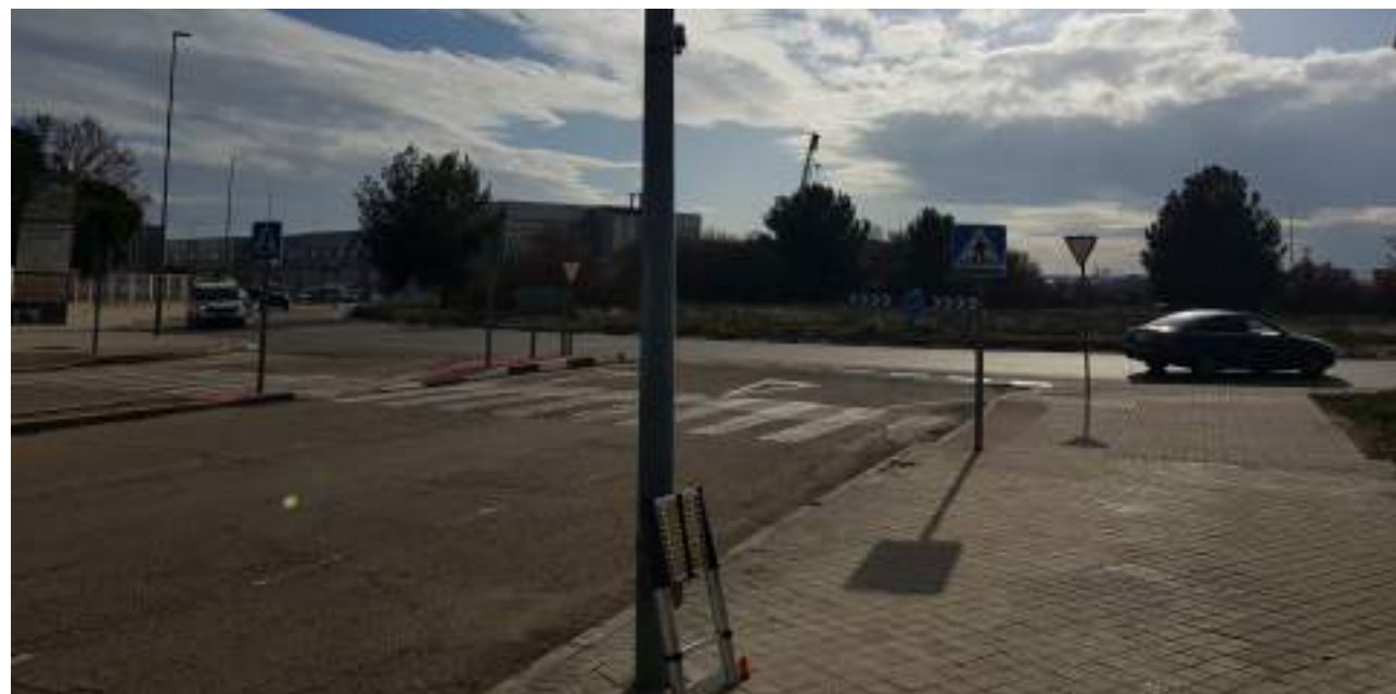
Imagen 11. Detalle de instalación de cámara de visión artificial en glorieta entre Av. Daganzo y Av. del Descubrimiento.
