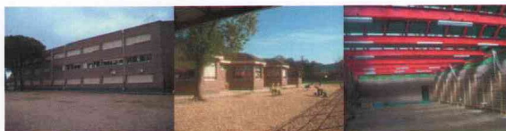
Fotog. 2.1. Edificaciones del centro docente Ciudad del Aire
